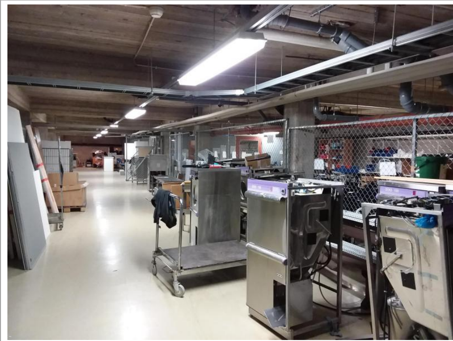
Yleiskuva varastotilasta. Varastotilan betonilattian kosteus on suurimmalta osin koholla Gann 95-119.
